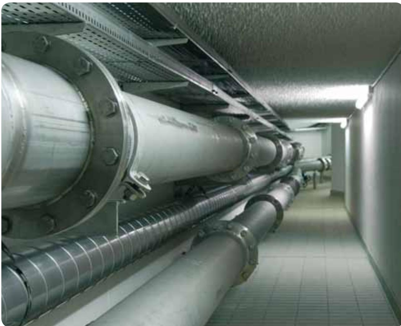
▲ Tunnel beim Wasserwerk mit Brunnenleitung, Hochbehälterleitung und Steuercabel
