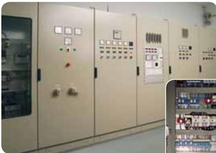
▲ Schaltschrank im Wasserwerk Lengfeld für die gesamte Steuerung der Wasserversorgungsanlage
