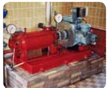
▲ Notfallpumpe mit Dieselantrieb im Pumpwerk Teugn
