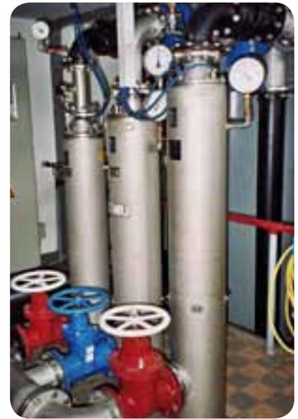
▲ Höherliegende Versorgungszonen werden über Drucksteigerungspumpwerke mit Trinkwasser versorgt.
