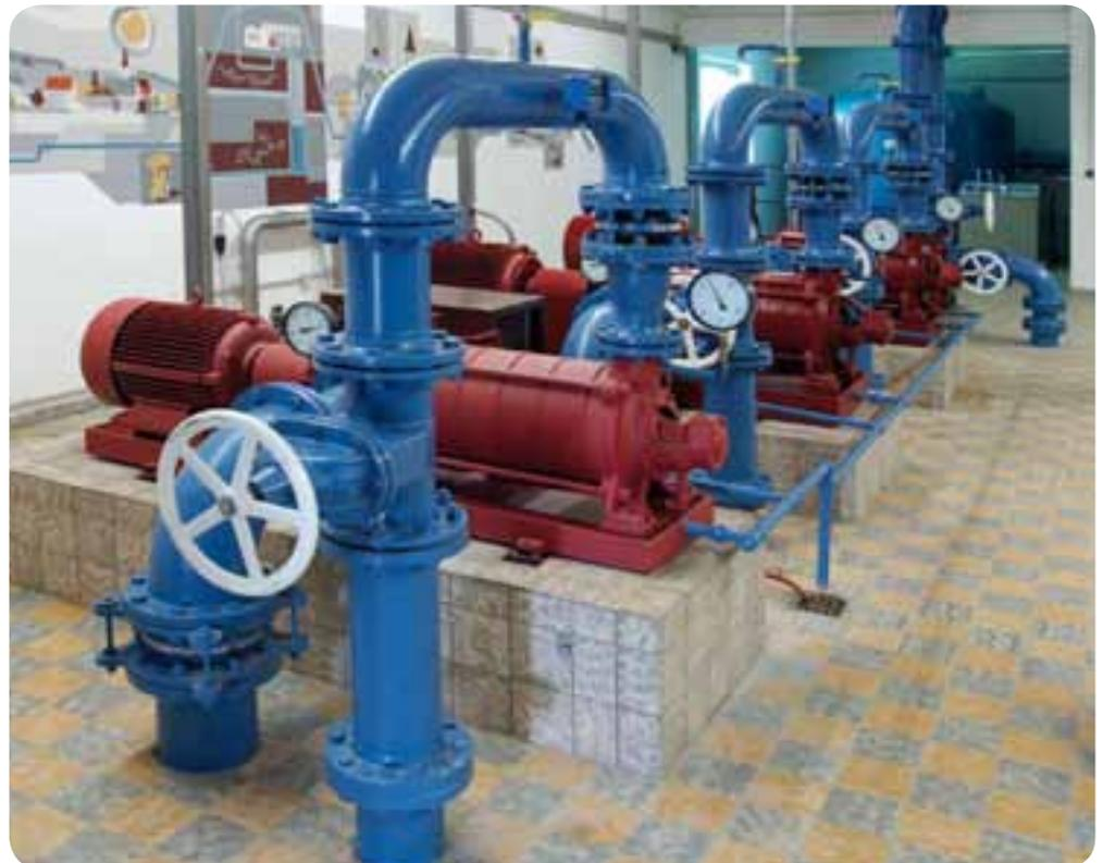
▲ Mehrere Pumpen im Wasserwerk fördern das Trinkwasser in das Rohrleitungsnetz bzw. in den Zentralhochbehälter Lengfeld
