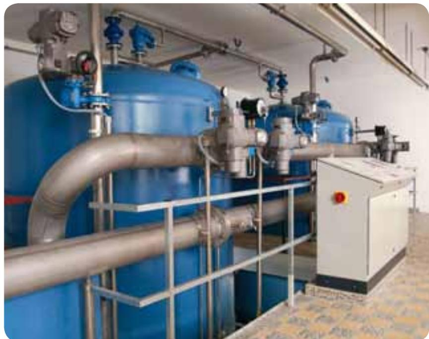
▶ Trinkwasseraufbereitungsanlage 1 im Wasserwerk Lengfeld. Baujahr: 1965, Leistung: 162 cbm/Stunde
