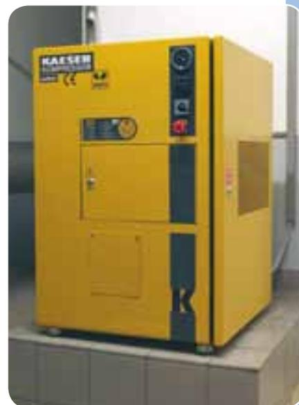
▲ Einer der beiden Kompressoren zur Belüftung des Trinkwassers
